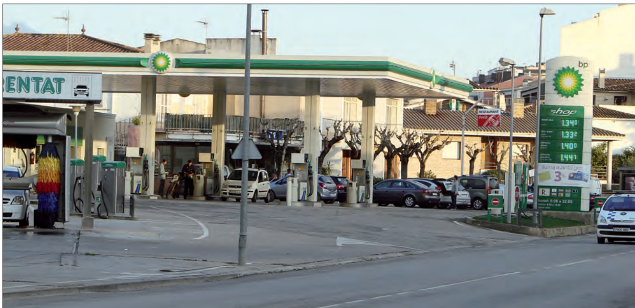
Vista general de la gasolinera Rabell. (Albert Viñas)
