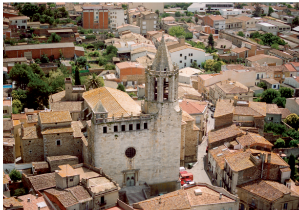
Figura 6. L'església de Sant Martí de Cassà, nucli de resistència contra els Montcada. Font: AMCS, Arxiu d'Imatges. Autor: Aviotec
